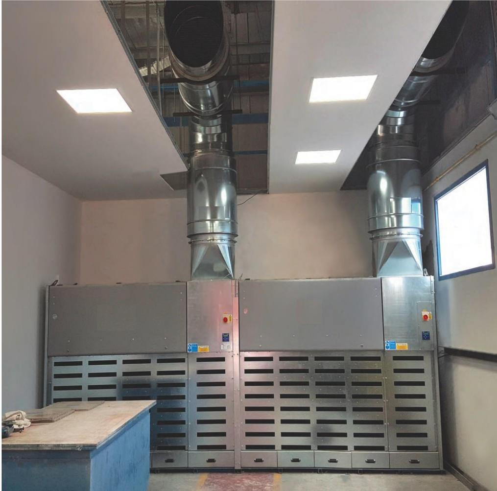
Die Plug&Play- Schleifwand Typ ZINCOCARDF vereint die Vorteile der Wartungsfreundlichkeit, Filtereffizienz und einfache Umpositionierung.
